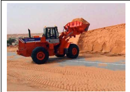
Photo 1 : dégagement des infrastructures routières. Cliché : DPN.
