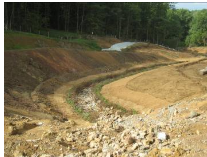
Le génie végétal en substitution des enrochements
