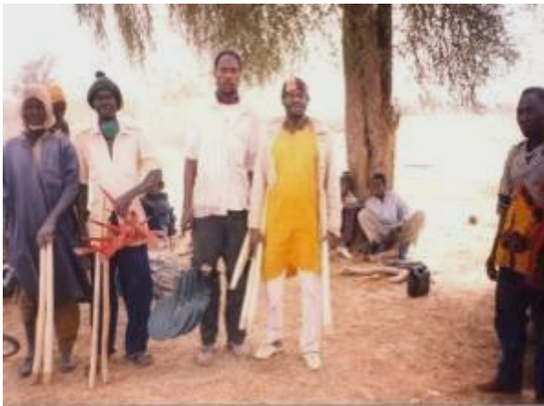
Photos 7, 8 et 9 : petit matériel de chantier mis à la disposition des déplacés : pioches, pelles, moules, brouettes, etc. (Photos de Boureima NÉBIÉ)
