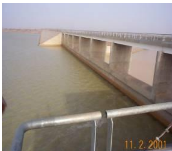
Photo 2 : déversoir du barrage de Ziga (Boureima NEBIE)
