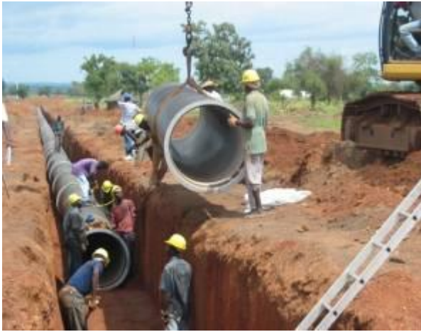
Photo 3 : pose de la conduite principale (Boureima NEBIE)
