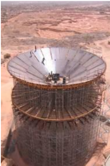
Photo 5 : coffrage de la coupole d'un château d'eau (Boureima NEBIE)
