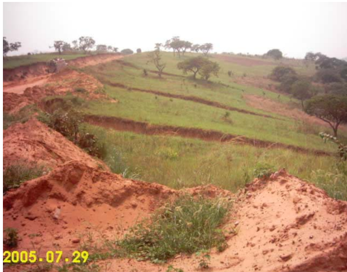
Photo 2 : Aperçu des érosions le long des pentes dans le bas côté de la route
