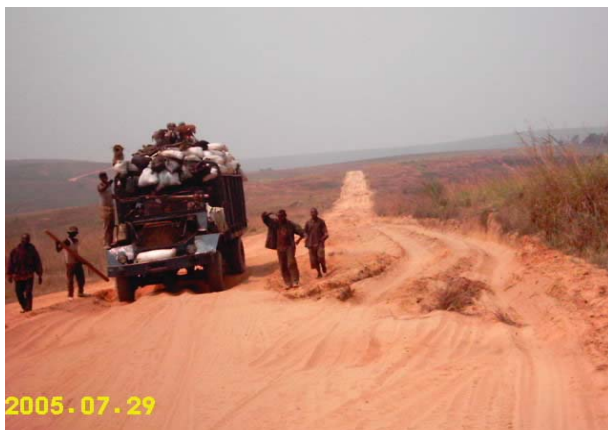
Photo 1 : Aperçu de l'état de dégradation de la route
